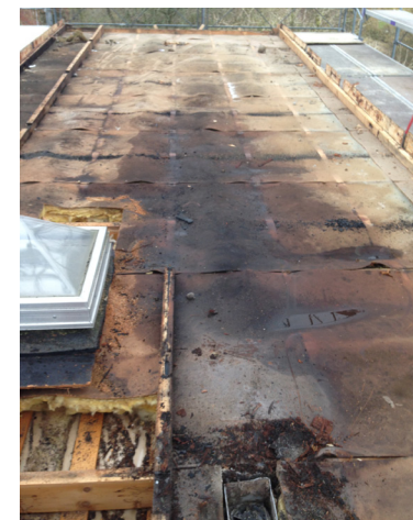
Eksisterende tag, hvor tagpapet er fjernet.
