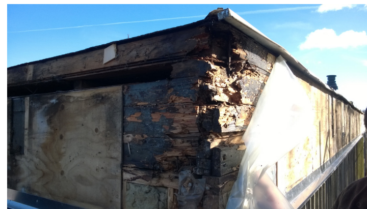
Eksisterende tag, hvor tagpapet er fjernet.
