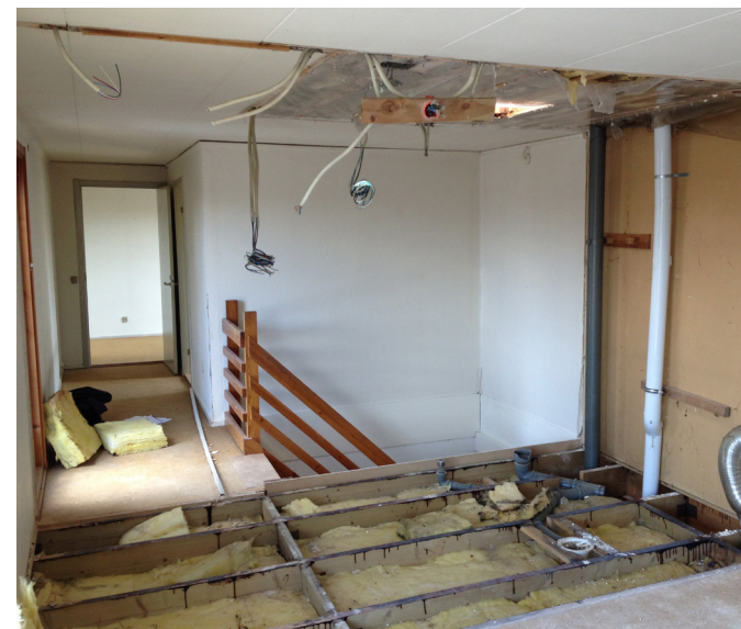
Nedbrydning af eksisterende badeværelse.
